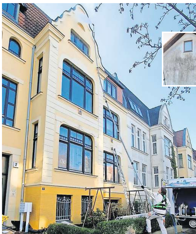
Dank eigener Teleskoptechnik sind auch große Höhen kein Problem mehr. Fotos: Holz Müller (3)
